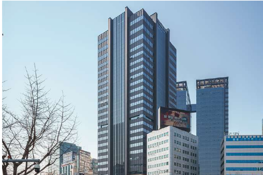
▲ 남대문로에 위치한 단암빌딩 전경, 대대적인 리모델링작업을 거친 모습이다. [사진 제공 = 포스코]
